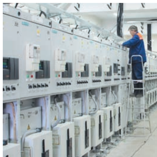
Монтаж электрооборудования на компрессорной станции в Володино
