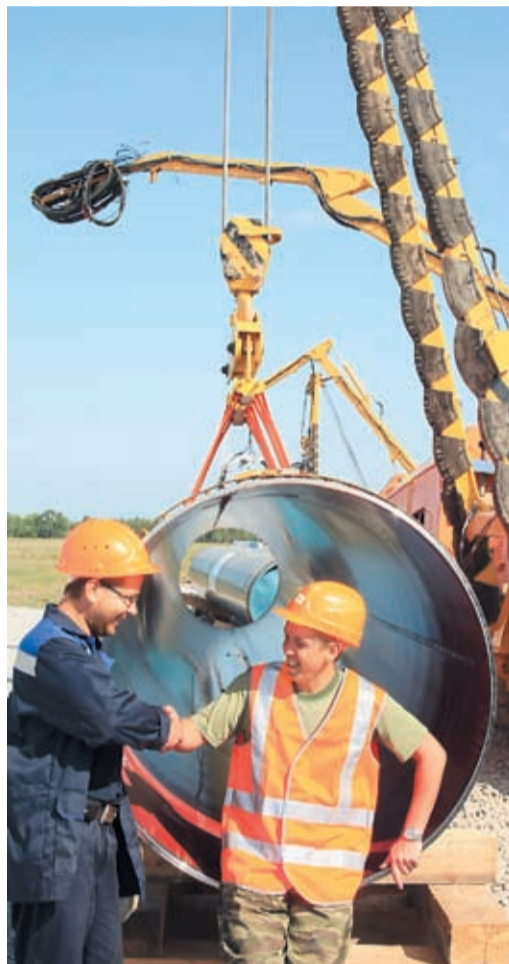
Подготовка и сварка стыка установкой автоматической сварки. Современные технологии на вооружении газовиков обеспечат надёжность работы газовой магистрали
