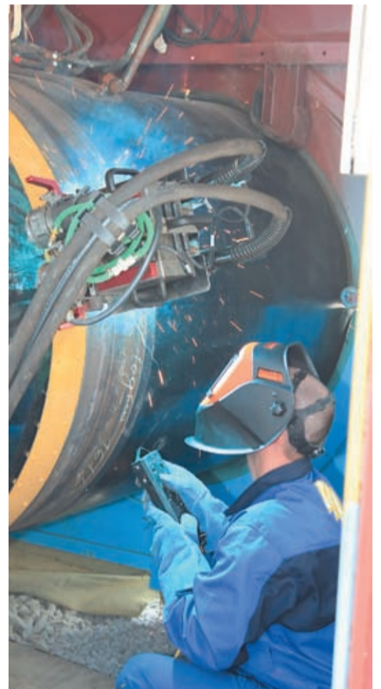
Подготовка и сварка стыка установкой автоматической сварки. Современные технологии на вооружении газовиков обеспечат надёжность работы газовой магистрали
