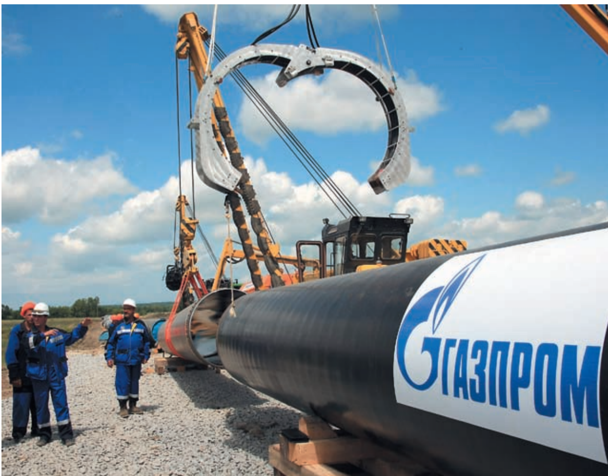
Подготовка труб для сварки в плетё. Совсем скоро будет положено начало великой стройки
